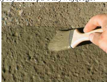
Rys. 1. Nakładanie warstwy szczepnej przed nałożeniem warstwy reprofilacyjnej.
