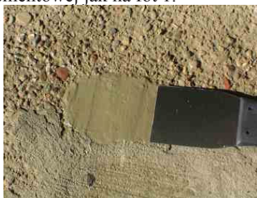
Fot. 1. Wygląd zaprawy w trakcie szpachlowania.
