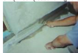
Fot. 3. Uszczelnienie pasem szerokości 10cm styku płyty tarasu ogrzewanego ze ścianą.
