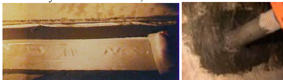
Fot. 1 i 2. Po lewej uszczelnienie całej powierzchni cienkiej niezbrojonej wylewki w zbiorniku przeciwpożarowym. Po
