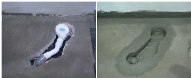
Fot. 4 i 5. Uszczelnienie miejsca pod brodzikiem natrysku: Po lewej nietypowy otwór pod odpływ z płytkiego brodzika wykonany w wylewce zbrojonej w pomieszczeniu natrysków. Po prawej uszczelniony otwór – gotowy do włożenia odpływu i uszczelniony styk posadzki ze ścianą.
