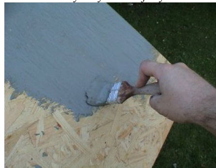
Fot. 2. Uszczelnienie wodoodpornej płyty wiórowej Hydrostopem-Elastycznym 1kg/m 2 .
