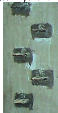
Fot. 2. Uszczelnienie Hydrostopem-Superelastycznym 2kg/m 2 styku powłoki penetrującej z metalowym osprzętem zbiornika przeciwpożarowego – widoczne klamry żelwne w ścianie pod włazem zbiornika.
